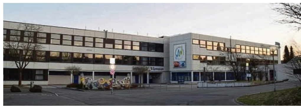
An den Winterberger Schulen, hier das Geschwister-Scholl-Gymnasium, werden Sanierungs-/Modernisierungsmaßnahmen durchgeführt.
